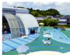
久米市民プール(R8完成予定)
