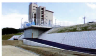
ポンプゲート整備計画を5年以上前倒し 令和4年7月に14基の整備を完了
