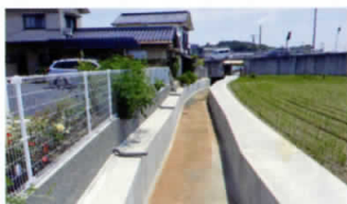
ゲリラ豪雨による浸水被害の 頻発等を受けた雨水幹線水路の整備
