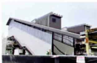
JR津山駅にエレベーター新設
