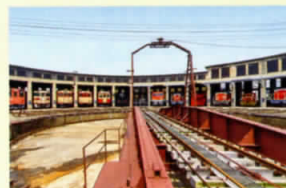
旧津山扇形機関車庫
